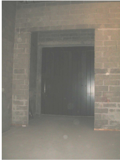
Entrée monte-charge relié au sous-sol du parking Italie 2
